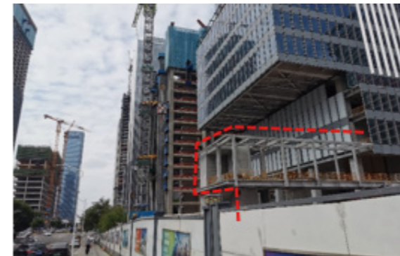
北侧招联项目预留天桥接口
