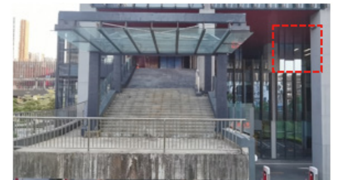
南侧梦工场项目预留天桥接口
